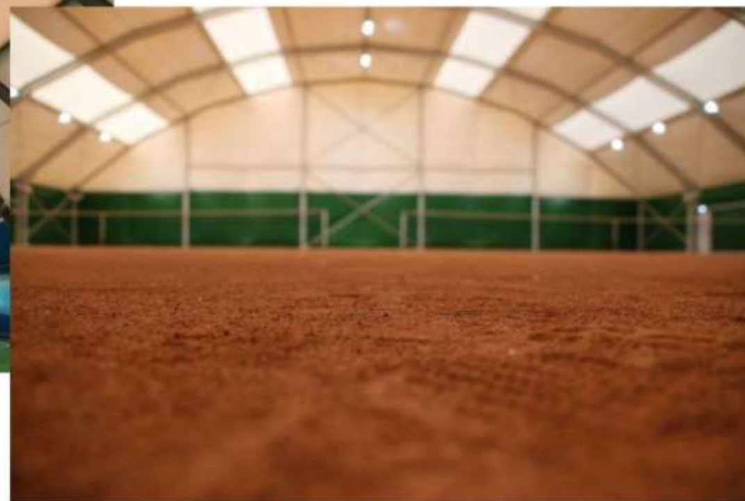
Konstrukcja łuków hali powyżej 24 metrów rozpiętości
