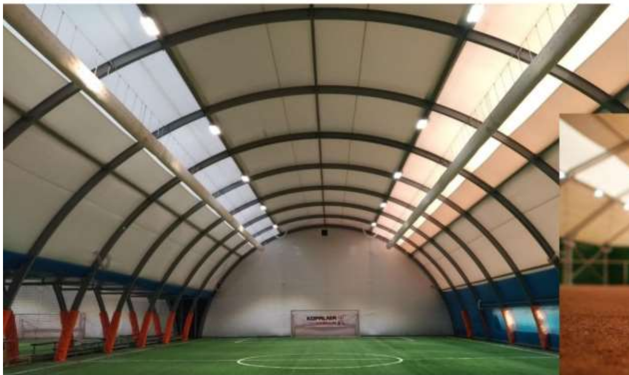
Konstrukcja łuków hali poniżej 24 m rozpiętości
