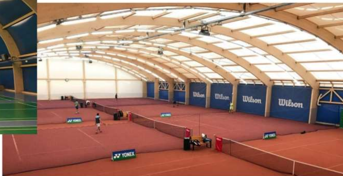
Konstrukcja łuków hali powyżej 24 metrów rozpiętości
